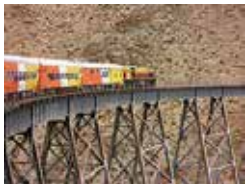
Disponible en https://upload.wikimedia.org/wikipedia/commons/thumb/0/0a/Tren_a_las_nubes_cruzando_Viaducto_la_Polvorilla.jpg/240px-Tren_a_las_nubes_cruzando_Viaducto_la_Polvorilla.jpg [ref. del 11 de julio de 2016]
